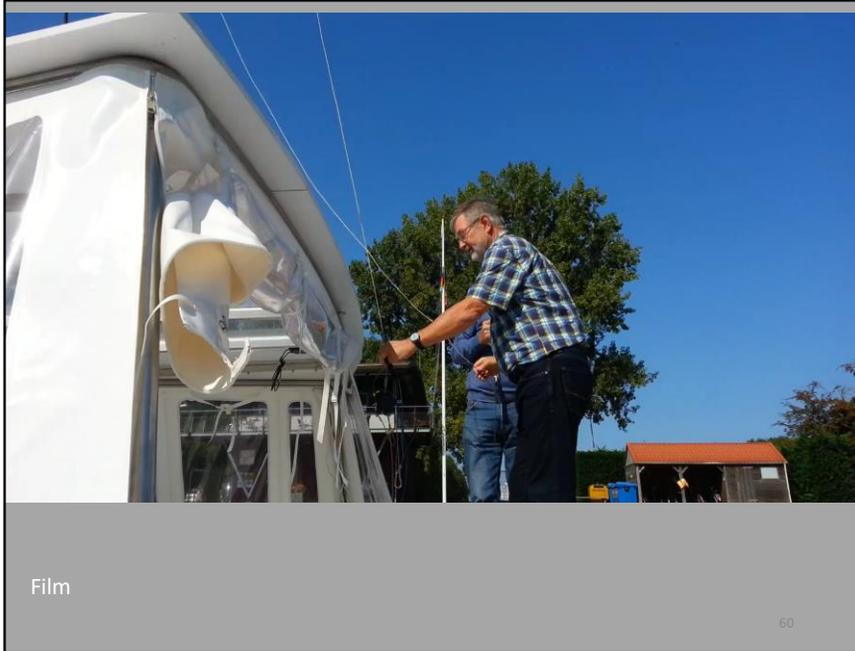
Dieser kurze Film zeigt, wie wir den Antennendraht über die Rolle bis zu dem isolierten Drahtstück herunterholen.
